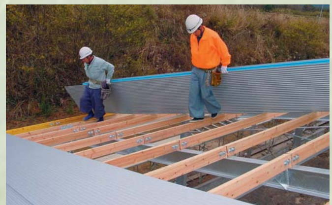
施工例 ウッドラックGS（屋根※特殊加工品）
